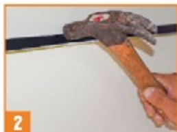
2 Colocar ángulos con clavos 2 x 20 en el perímetro de la pared.
