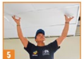
5 La colocación de las panchas se efectuará de manera superpuesta.
