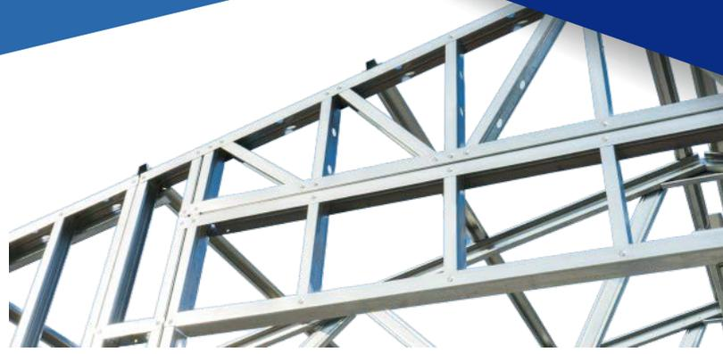
El Steel framing es un sistema constructivo, ampliamente utilizado en todo el mundo, por ser rápido, durable y resistente a sismos y fuego.
