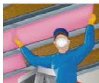
9.- Si la unidad eléctrica tiene las letras IC, puede instalar el aislamiento en contacto con el equipo de iluminación. De otro modo, coloque el aislamiento a una distancia de 7.6 cm del equipo.
