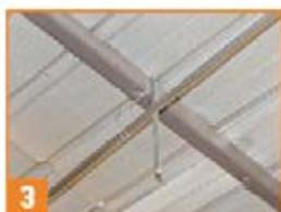
3 Colocar el perfil primario T12 (riel). Sujetar al techo con el uso de alambre (#16 o #18).
