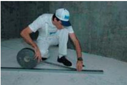
La Banda perimetral acústica de Knauf, es una cinta superficial de espuma de poliuretano elástica, duradera, de celdas cerradas, autoadhesiva en una cara, de color gris.
